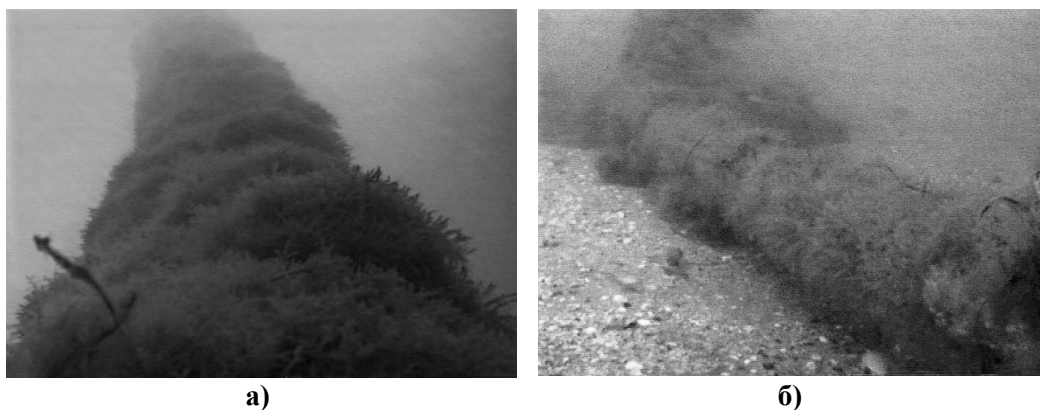
Рис. 3.3 Пелагический модуль рифа из полипропиленовых волокон (а) и донный модуль рифа из полипропиленовых канатов (б)
